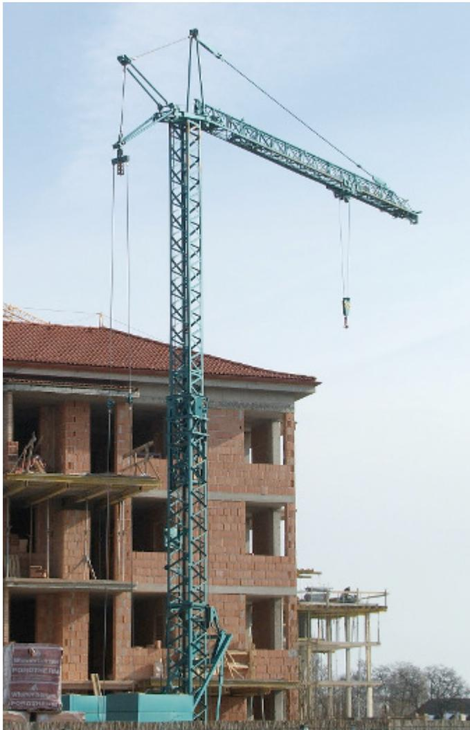
*Potain Schnellmontagekran der Baureihe Quadromatic aus Mitte der siebziger Jahre. Bei diesem Schnellmontagekran ist der Ausleger stufenlos teleskopierbar (**Teleskopausleger**) und lässt sich somit optimal der Baustelle anpassen. Auch der Turm ist stufenlos ausfahrbar. Foto Zsolt Czimbuli*
