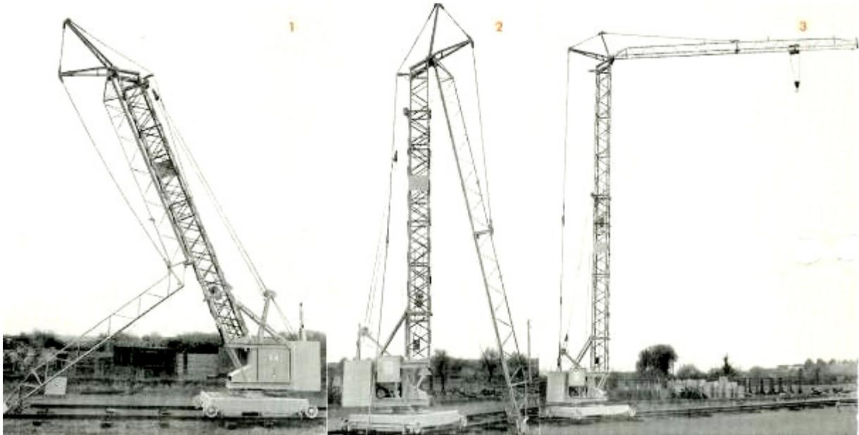
Montagefolgen des Cadillon Krans. Der Ablauf entspricht in etwa noch den alten **Nadelauslegern**. Auch der Aufbau des Krans entspricht den Vorgängern mit **wipbarem Ausleger**. Die Steuerung erfolgt mit **Schützensteuerung** und **Steuerbirne**, von welchem aus der Kran auch **ferngesteuert** werden kann.
