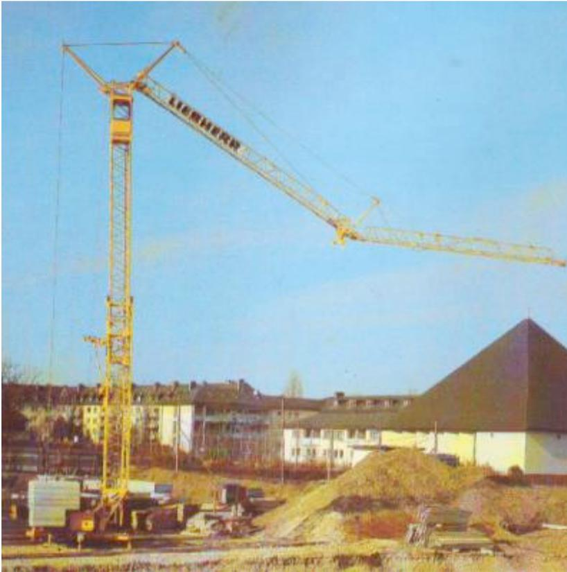
*Liebherr 21 K*. 1980 wurde mit diesem Kran die Ära der **Luftmontage** eingeläutet. Bei der Montage berührt die Auslegerspitze den Boden nie. Die **Luftmontage** wird mit einer Seileinscherung über einen **A-Bock** auf dem Ausleger erreicht. Bis dahin musste die Auslegerspitze mittels Brettern und Rolle an der Spitze mühsam am Boden entlang aufgezogen werden, was bei unebenem Gelände recht schwierig ist. Der **Betonballast** kann mit einem **Hilfsgalgen** selber aufgelegt werden.
