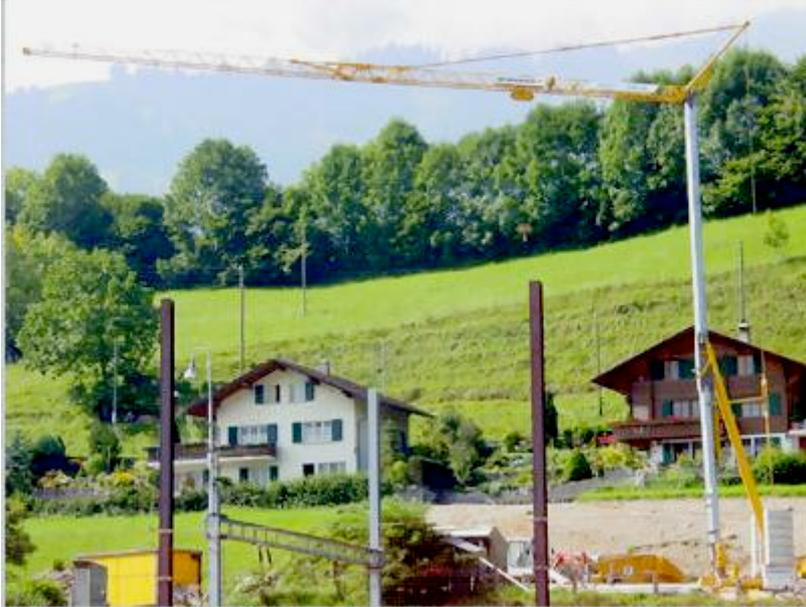
Moderner **hydraulischer Schnellmontagekran Potain HD**. Die Montage des Kranturms und des Auslegers erfolgt mit **Hydraulikzylinder**. Die Montage ist einfach und schnell. Bei horizontalem Ausleger ist nur eine Hakenhöhe möglich, was im Verbund von mehreren Kranen Probleme bereiten kann. Foto Andreas Bruderer
