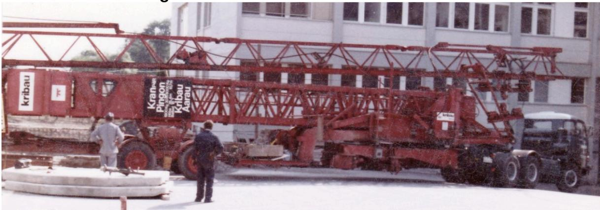
Grosse Schnellmontagekrane werden als **Sattelaufleger** transportiert. Es kommen sowohl **Langsamläufer** als auch **Schnellläufer** zum Einsatz. Im Bild ein Pingon P4R aus den siebziger Jahren, mit gewaltiger Transportlänge von 22 m.
