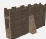
Burg Tecklingen MauerAusbau
